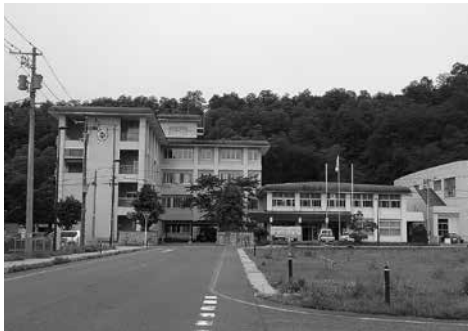
多くの職員が働く役場庁舎
