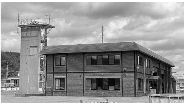
消防署小坂分署のサイレン
