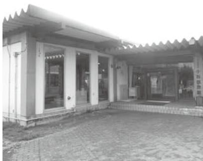
小坂図書館（エアコン更新予定）
