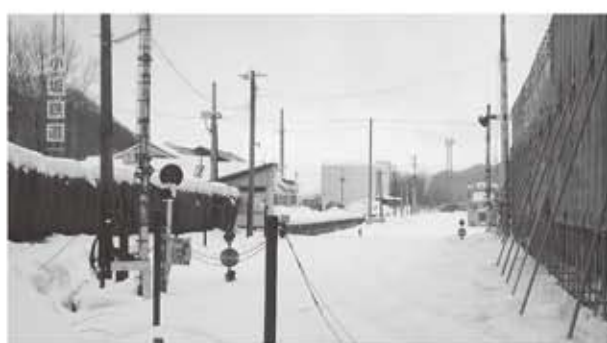
整備が進む小坂駅構内
