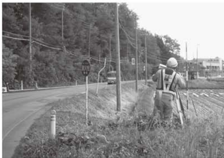
歩道新設工事中の国道282号（大生手付近）
