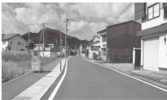
工事完成となった川通り線
