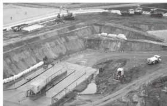
グリーンフィル小坂の最終処分場
