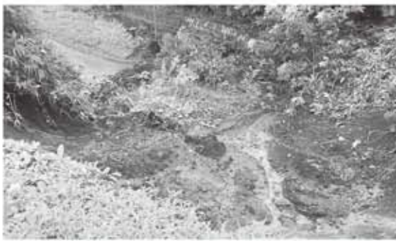
ゲリラ豪雨により土砂崩れが起きた万谷地内
