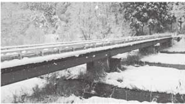
上川原の橋の現状
