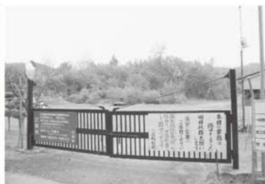
◀不燃物最終処分場
