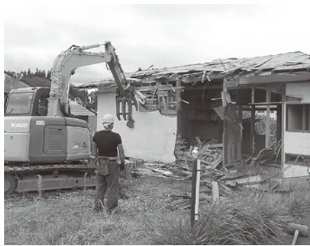
空き家解体作業
