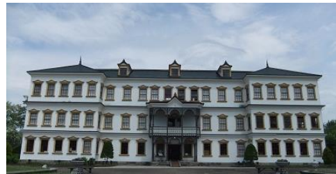
小坂鉱山事務所
