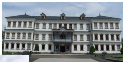
小坂鉱山事務所
