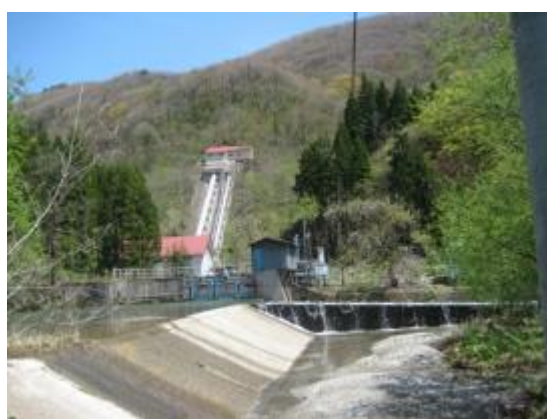
新大楽前発電所
