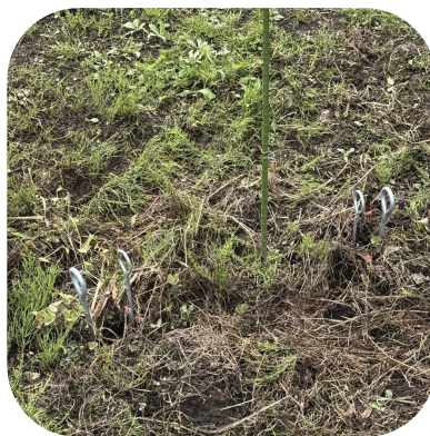
アンカーは地中深くで先端が開きしっかり根を張るしくみです。
