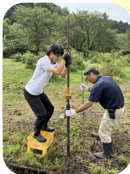
ガイドパイプとハンマーでアンカーを打ち込んでいきます。重い！！
