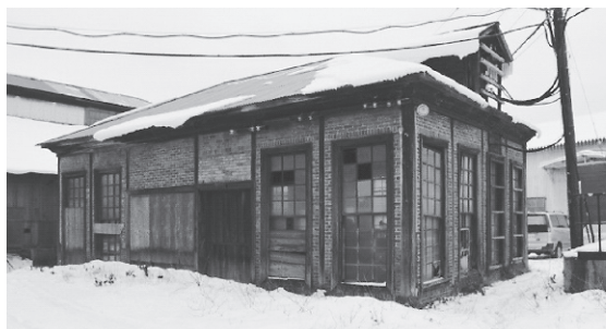
▲小坂製錬から譲渡される予定の建物
