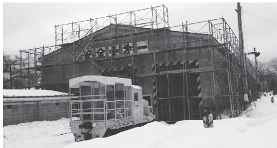
▲完成間近の「体験館」(機関車庫)
