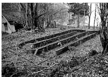
小坂町指定史跡「旧和井内ヒメマスふ化場」
